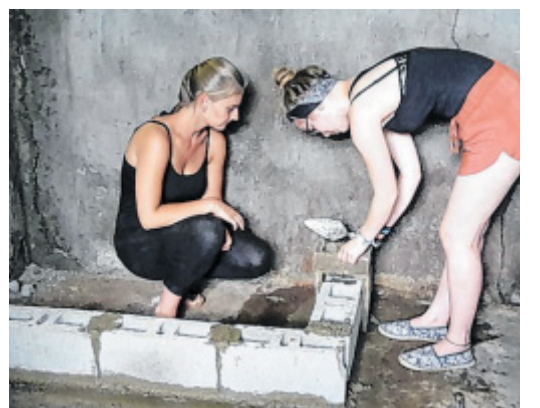
Stein auf Stein: Die Jugendlichen helfen dabei, holzbetriebene Öfen zu bauen.
