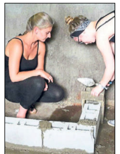
Die Jugendlichen helfen dabei, einen holzbetriebenen Ofen zu bauen.
